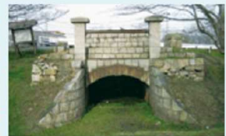
▲常川樋門 (南区西紅陽台)
