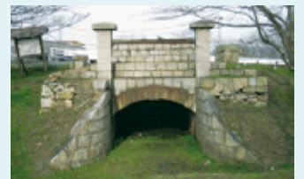
▲常川樋門 (南区西紅陽台)
