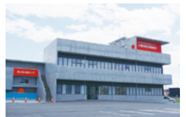
▲水難救助訓練施設 (南区浦安南町)
