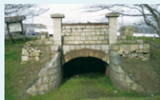
▲常川樋門 (南区西紅陽台)
