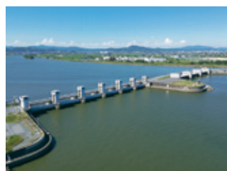
▲百間川河口水門
