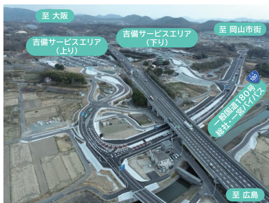
吉備スマートインターチェンジ24時間化・大型車対応 (令和8年2月1日開通)
