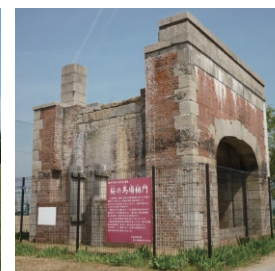
桜の馬場樋門
