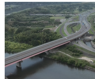
主要地方道岡山吉井線 (新大原橋拡幅)
