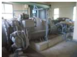
農業用排水機場
