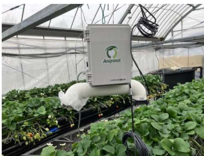
いちごハウスに設置した環境制御システム(R4 年度)
