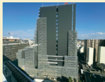
▲西面の外装の進捗状況
