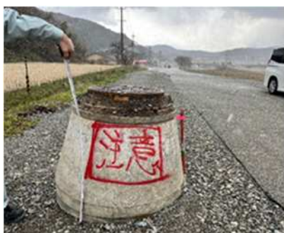
2024年能登半島地震における岡山市からの災害支援時の写真 (液状化によるマンホール浮上(左)、管きよの破損状況(右))
