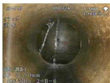
不明水の管内調査状況
