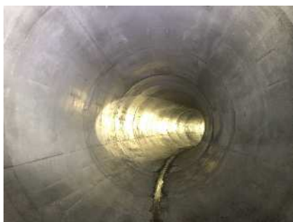
完成した浦安11号雨水幹線（1工区） （内径 3.75m）
