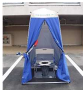
マンホールトイレの設置状況
