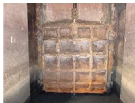
老朽化した設備のイメージ（雨水ポンプ設備（左・中）、流入主ゲート（右））
