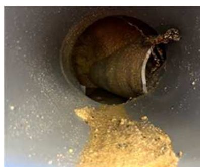
2024年能登半島地震における岡山市からの災害支援時の写真 (液状化によるマンホール浮上(左)、管きよの破損状況(右))
