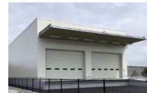
集中備蓄倉庫
