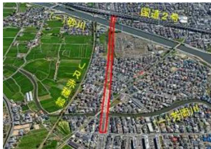
市道西大寺上中川町1号線整備状況
