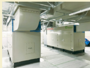
▲5階の発電機室に設置された非常用発電機
