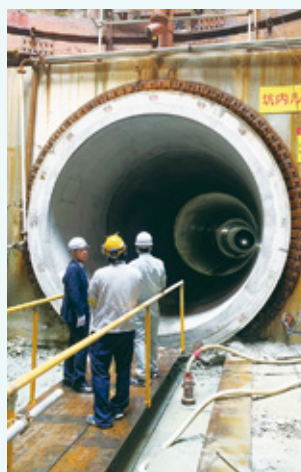
市長が工事現場を視察する様子
