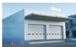
▲集中備蓄倉庫
