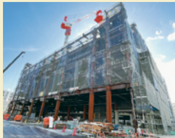
▲鉄骨の組み立て状況 (令和6年10月時点)
