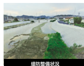
堤防整備状況
