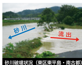
砂川堤防決壊状況 (東区東平島・南古部)
