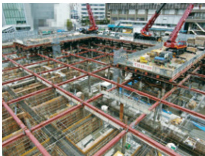
▲地下工事の状況 (令和6年3月中旬時点)
