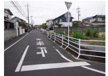
設置された転落防止柵 (中区八幡東町地内)
