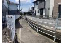
用水路の転落防止対策 ほか
