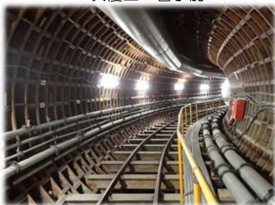
二次覆工 着手前
