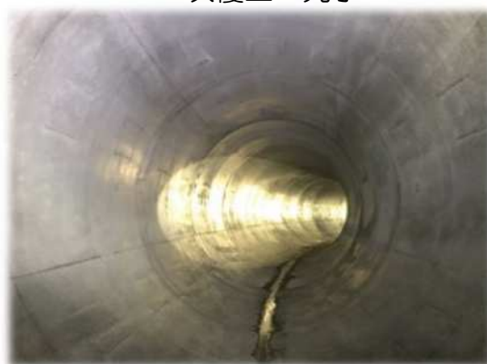
二次覆工 完了
