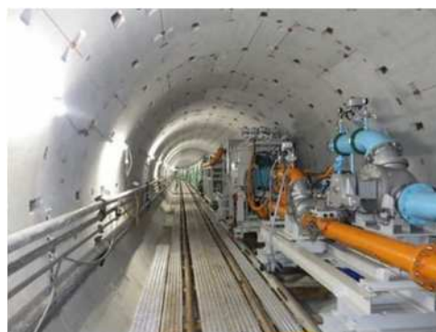
浦安11号幹線雨水管 施工状況
