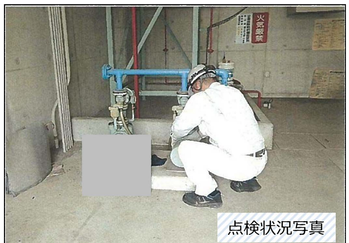
点検状況写真
