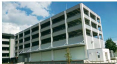
▲北長瀬未来ふれあい総合公園 立体駐車場（1階が備蓄倉庫）
