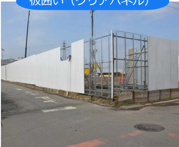
仮囲い（クリアパネル）
