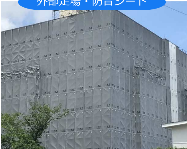
外部足場・防音シート
