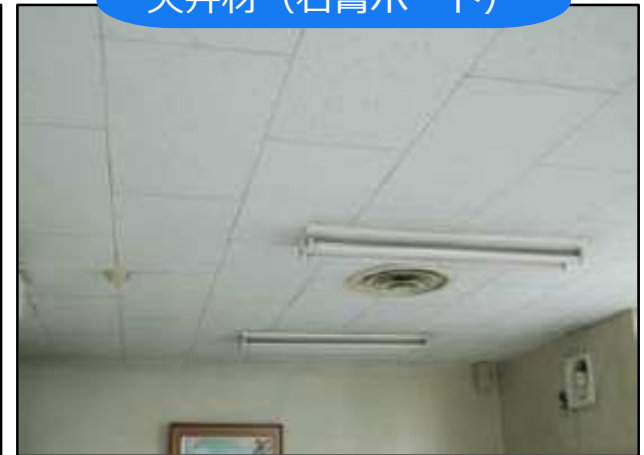
天井材 (石膏ボード)
