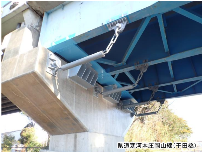
落橋防止構造の設置による耐震化
