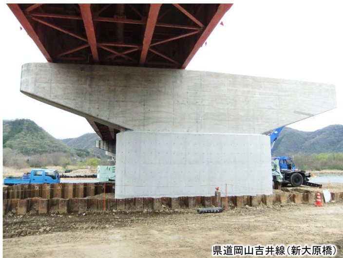
橋脚の補強による耐震化
