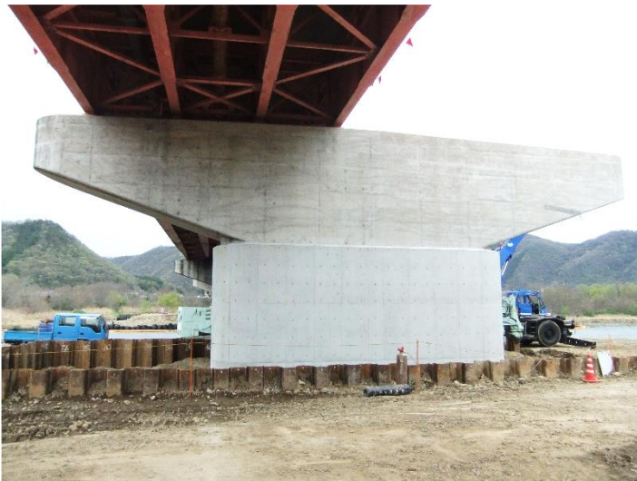
橋脚の補強による耐震化
