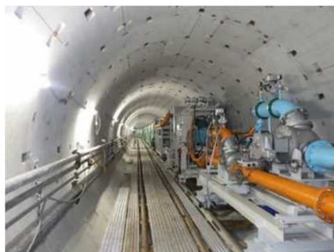
浦安11号幹線雨水管 施工状況(令和4年1月)
