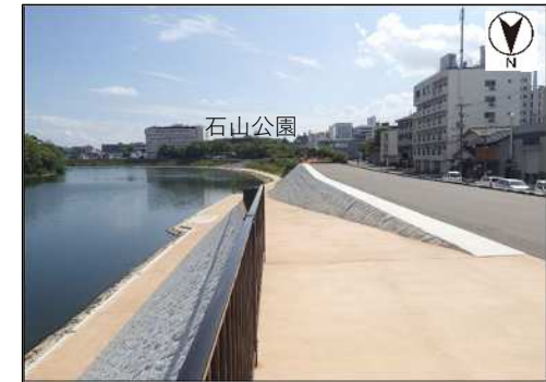
②北から南を望む (遊歩道への坂路)
