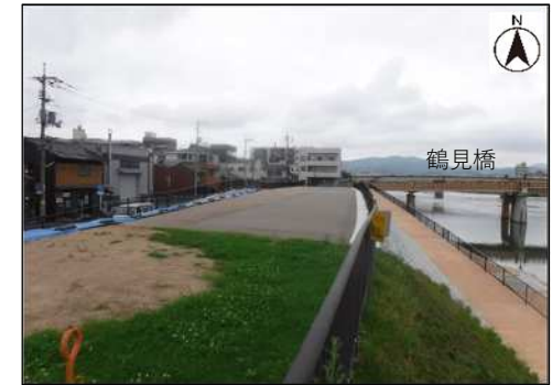
④南から北を望む
