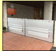
止水板設置状況(北区)
