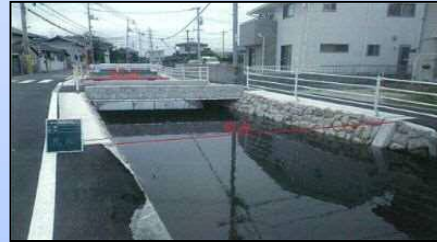
倉安川改修工事
