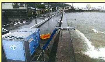
リースポンプによる排水状況 平成28年9月 台風16号
