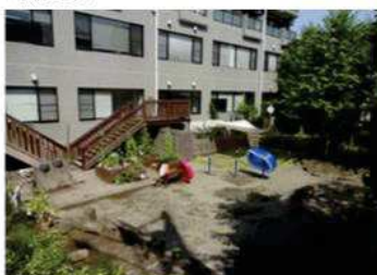
都内のビルと駐車場を改装したコンパクトな校舎。
