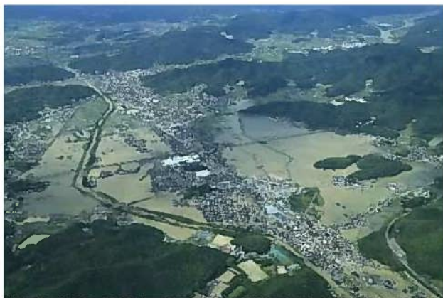
旭川水系破堤による浸水（東区平島地域） （撮影：アジア航測株式会社）
