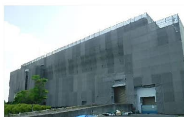
岡東ポンプ場耐震化
