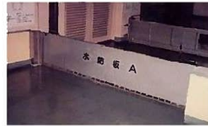
防水板の設置
