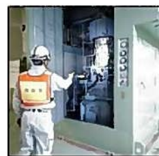
下水道施設の点検調査
