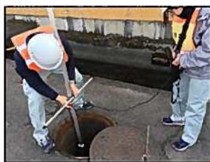
管口カメラによる下水道管調査
