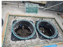
地下タンクマンホールを 水密マンホールに取替
