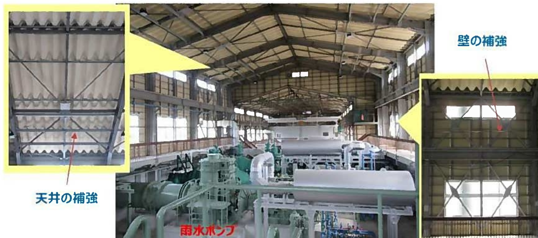
笹ヶ瀬ポンプ場の耐震化
