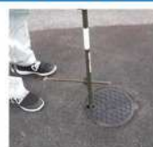
①マンホールの蓋を開ける
