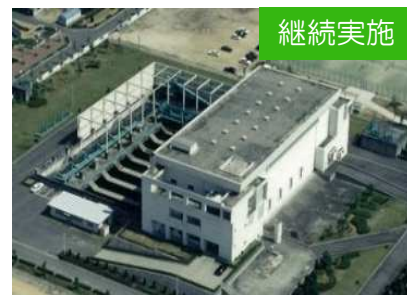
岡東ポンプ場改築更新（その3）
