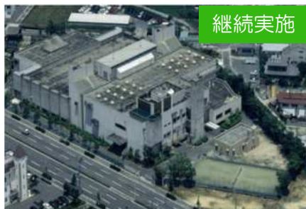
平井排水センター改築更新（その2）
