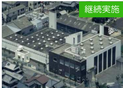
金岡ポンプ場改築更新（その2）
