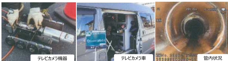
テレビカメラ調査状況
