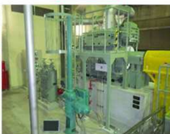
雨水ポンプ用ディーゼルエンジン更新完了
