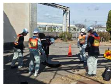
管口カメラによる下水道管調査
