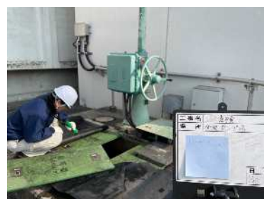
下水道施設の点検調査
