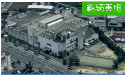
平井排水センター改築更新（その2）
