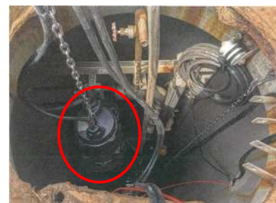
省エネ型マンホールポンプ更新作業
