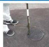
①マンホールの蓋を開ける
