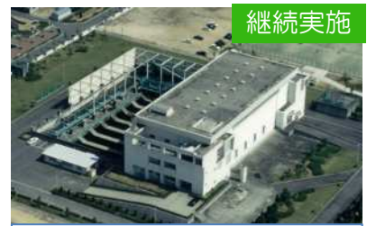
岡東ポンプ場改築更新（その3）
