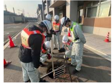
管口カメラによる下水道管調査
