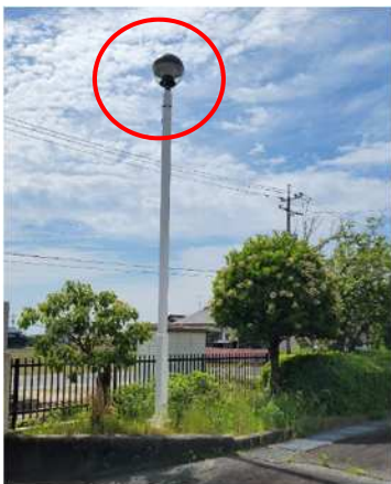
政津ポンプ場屋外灯LED化
