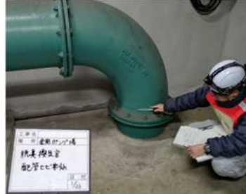
下水道施設の点検調査
