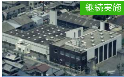
金岡ポンプ場改築更新（その2）
