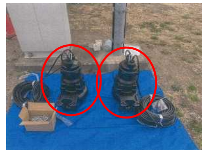
省エネ型マンホールポンプ搬入状況
