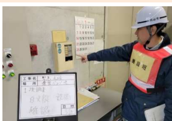
下水道施設の点検調査
