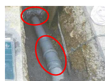
取付管接合部・継手補修
