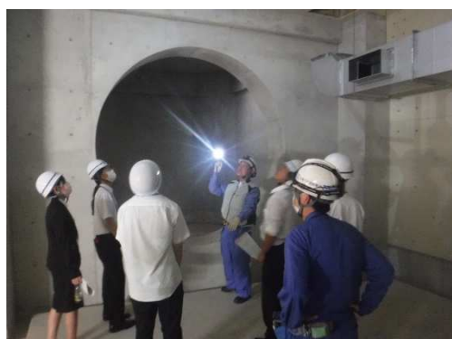
建設現場視察
