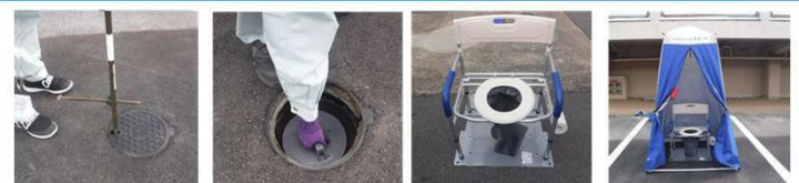
①マンホールの蓋を開ける ②内蓋を取る ③トイレ設置 ④TENT設置
