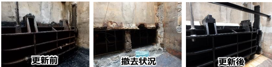
天瀬ポンプ場 流入ゲート更新
