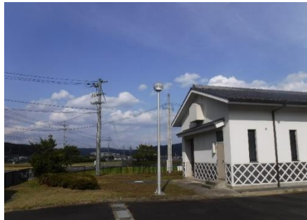
建部浄化センター照明設備LED 外灯4灯 約3,110kWh/年削減
