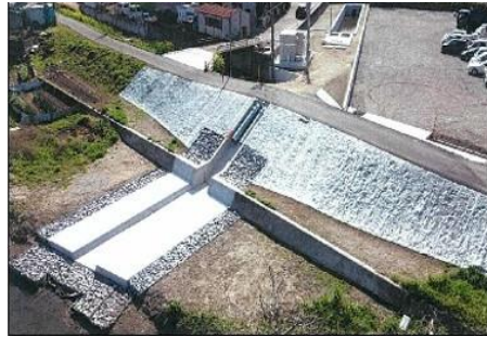
排水機場整備 (南区植松地区)
