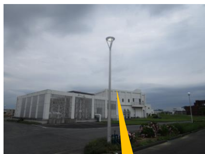
岡東浄化センター照明設備LED化 外灯14灯 約15,900kWh/年削減
