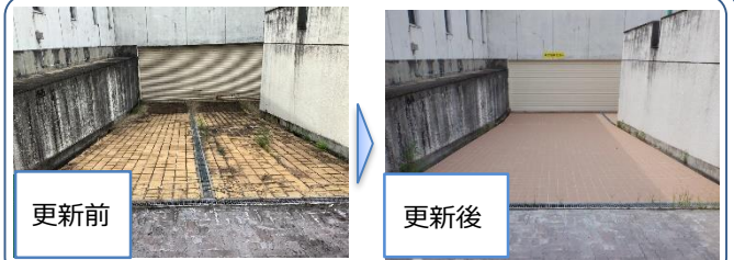
搬出スロープ更新
