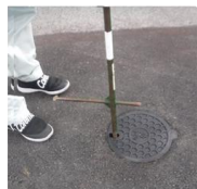
①マンホールの蓋を開ける
