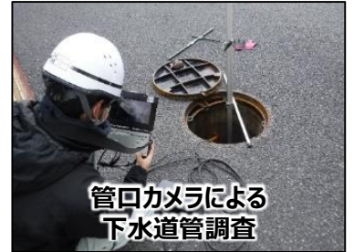
管口カメラによる 下水道管調査
