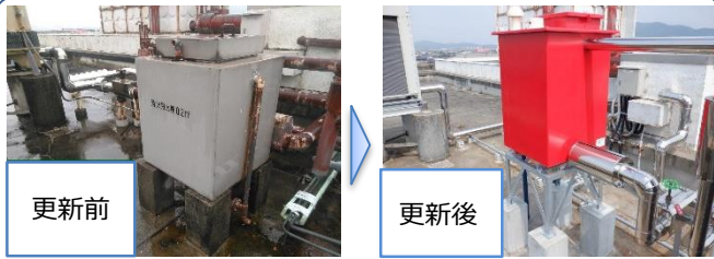
消火用水槽更新
