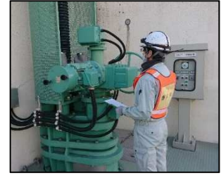
下水道施設の点検調査
