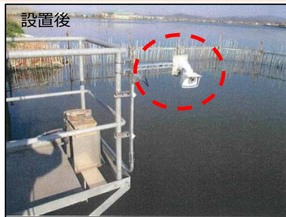
排水機場監視カメラ設置工事
