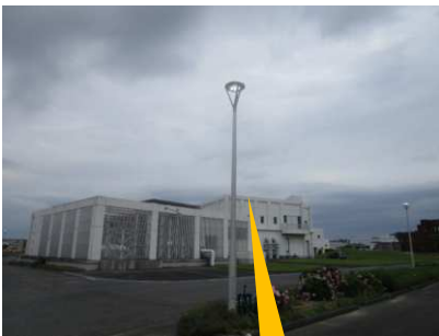
岡東浄化センター照明設備LED化 約23,500kWh/年削減
