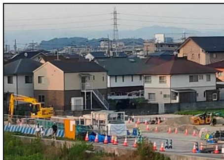
今保ポンプ場着手状況
