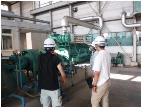
ポンプ場・処理場の見学
