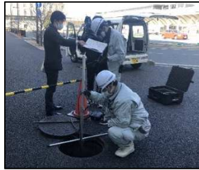
管口カメラによる下水道管調査
