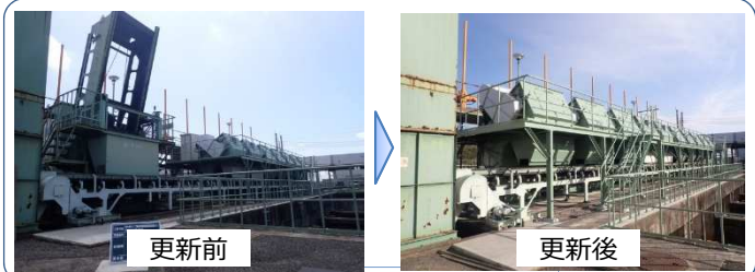
笹ヶ瀬P場自動除塵機更新
