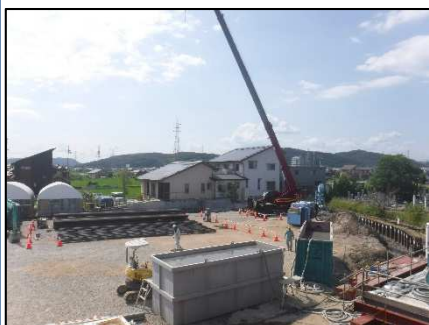
白石ポンプ場着手状況
