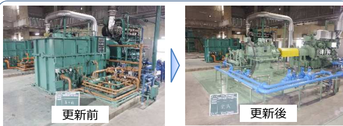
岡東P場No.4雨水ポンプ更新
