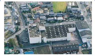
金岡 P場改築更新工事（着手）
