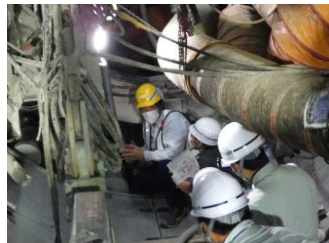
浦安11号雨水幹線の工事現場見学
