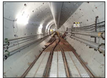
浦安11号雨水幹線整備状況
