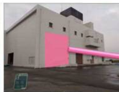
耐震壁による補強
