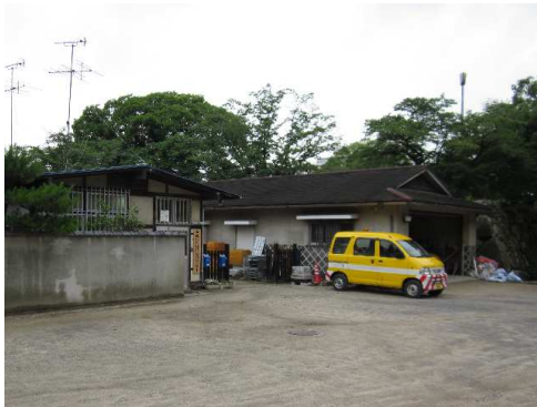
47・48. 中区維持管理事務所と車庫
