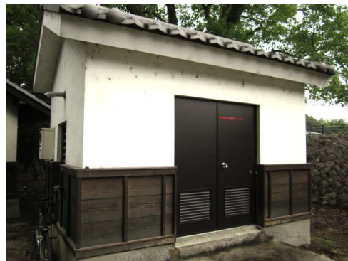
51. 月見櫓防災設備消火ポンプ室
