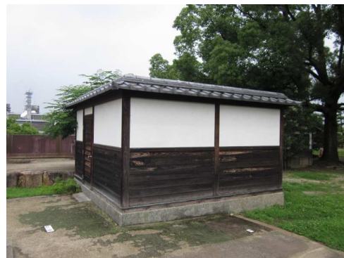
52. 消火ポンプ室
