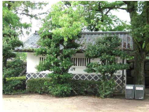
49. 公衆トイレ（内下馬門内）
