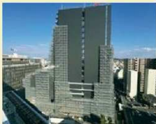
▲西面の外装の進捗状況
