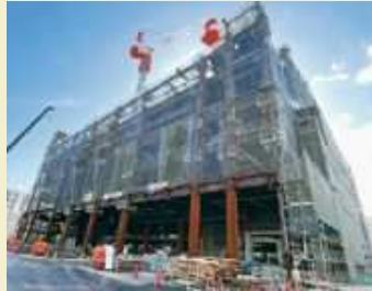
▲鉄骨の組み立て状況 (令和6年10月時点)
