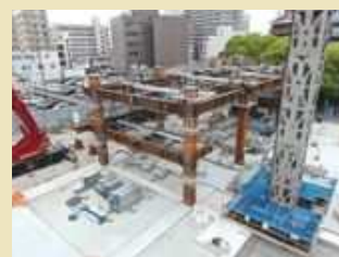
▲組み上がった地上部分の鉄骨 (6月中旬時点)
