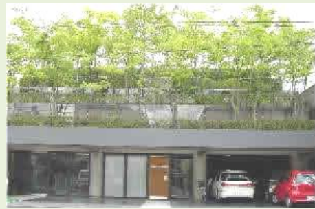
写真：屋上緑化
