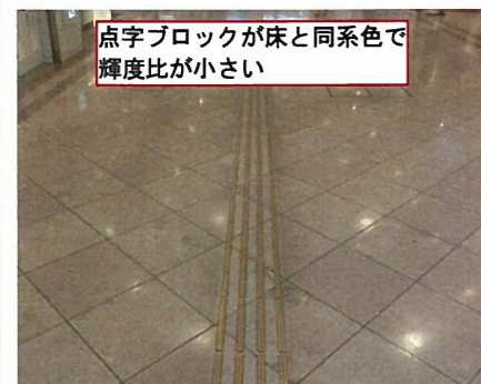
図. 視覚障害者誘導ブロック
