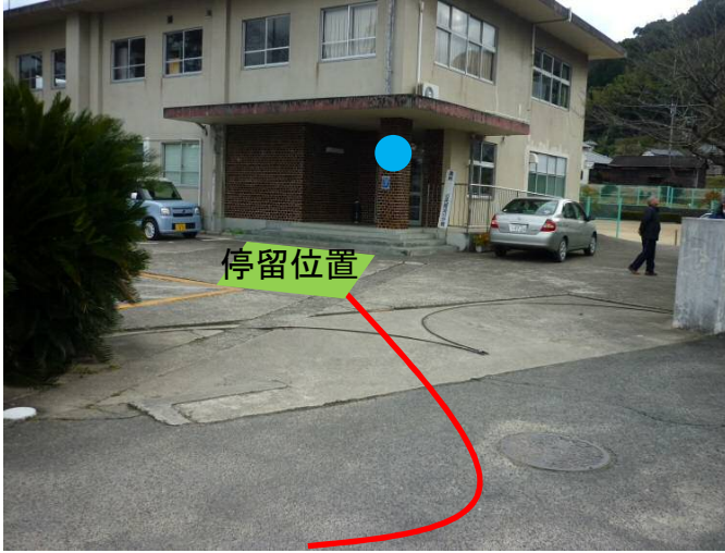
《写真①》施設出入口
