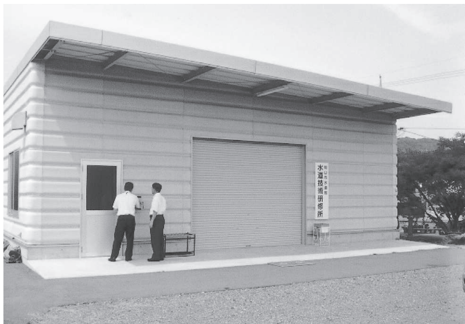
水道技術研修所の写真
