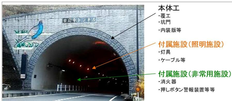
図 1.2 トンネル構造
