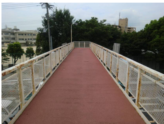
高欄の塗膜劣化, 腐食
