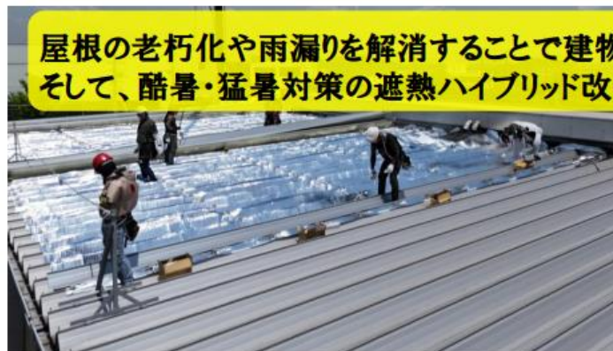
屋根遮熱改修：操業を止めずに工事ができます！
