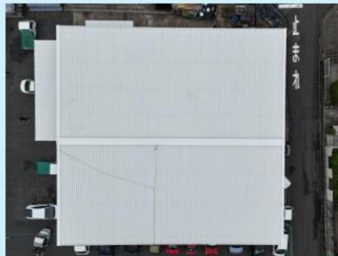
施工後の屋根
