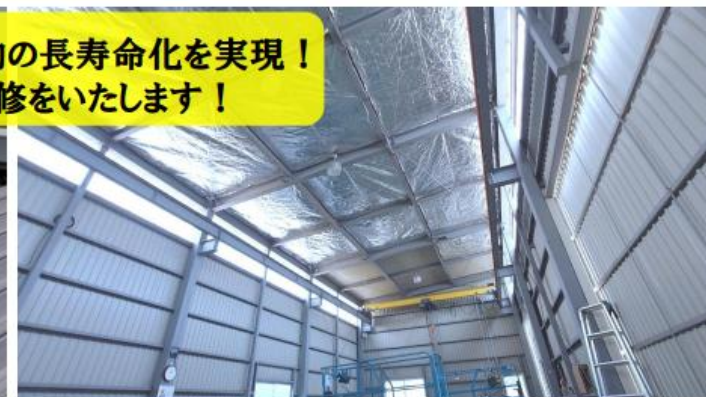
天井遮熱改修：工期短縮、リーズナブルな猛暑対策を実現！
