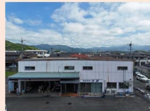
施工前の外観
